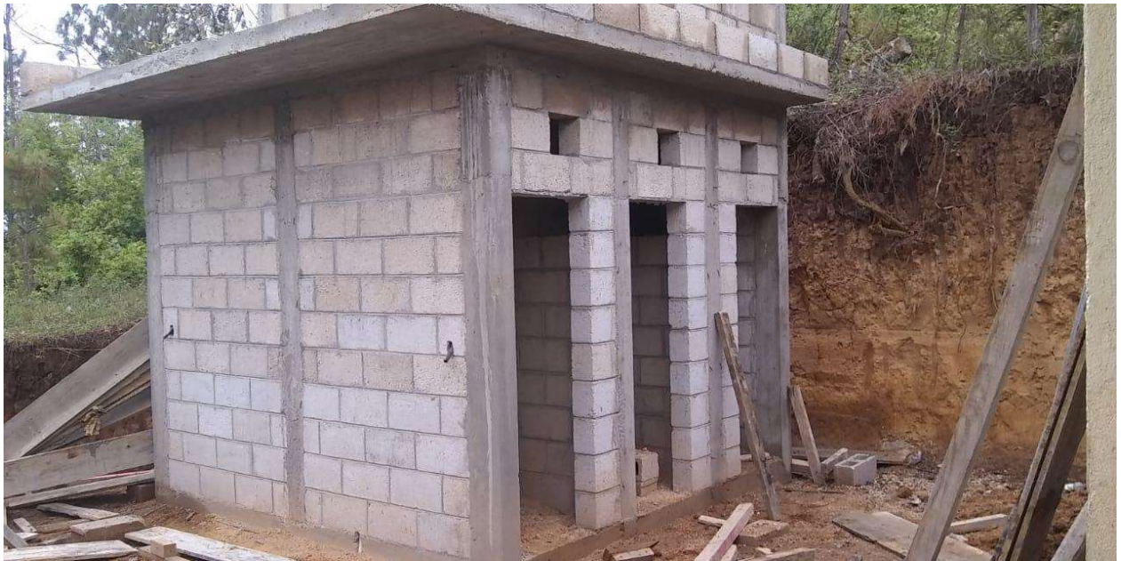
Baustelle der neuen Toiletten, Wasserpumpe und Wasserspeicher
