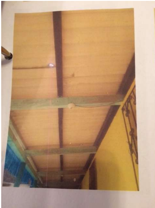
vor der Sanierung: Löcher auf dem Dach und Holzstützen morsch
