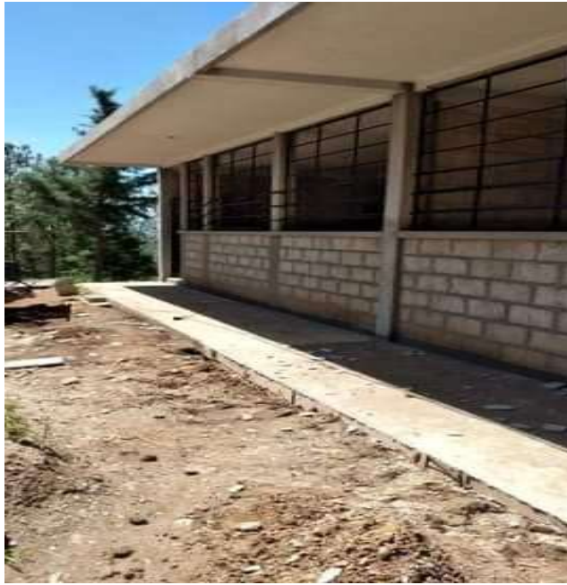
Die Fenster wurden montiert
