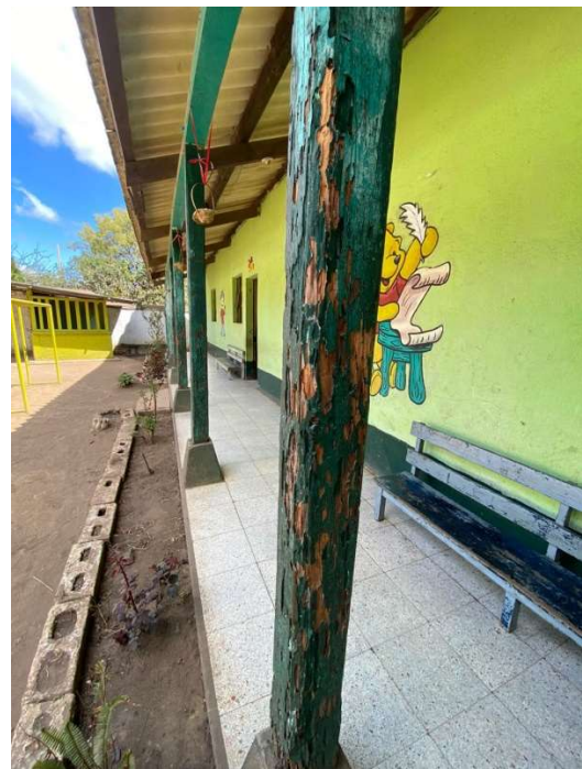
vor der Sanierung: Löcher auf dem Dach und Holzstützen morsch
