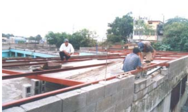
Sanierungsarbeiten am Dach
